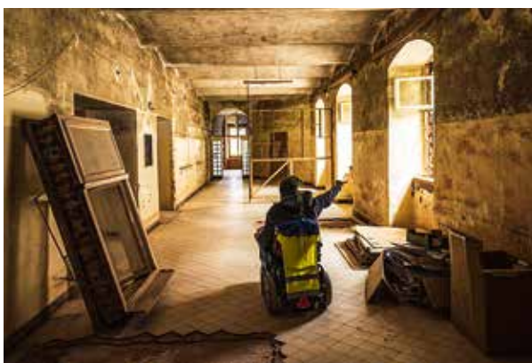
Manželé Fučíkovi mohou být právem hrdí na odvedenou práci. Zbývá dodělat poslední patro.
